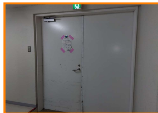
写真 資機材置場①
